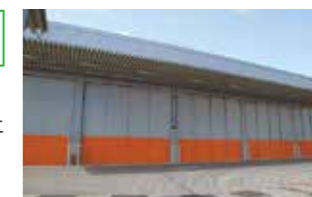
廃棄物一時保管場所 外観
