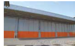
廃棄物一時保管場所 外観
